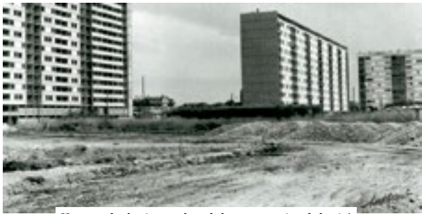
Une vue des bâtiments lors de la construction de la cité du Grand-Parc à Bordeaux en 1963.
