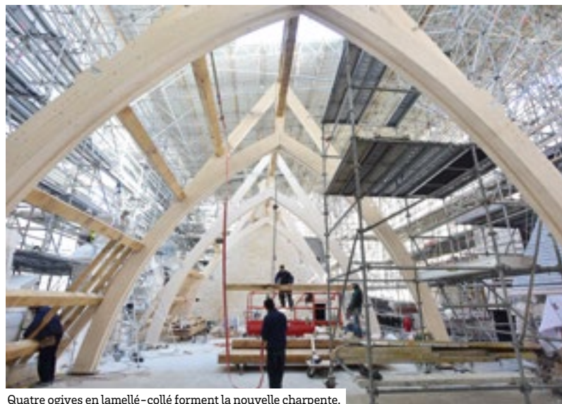
Quatre ogives en lamellé-collé forment la nouvelle charpente.
