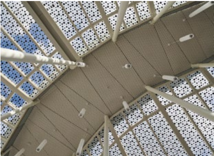
La grande canopée de verre a nécessité une étroite collaboration entre architectes, bureau d'études et entreprise de charpente métallique.
